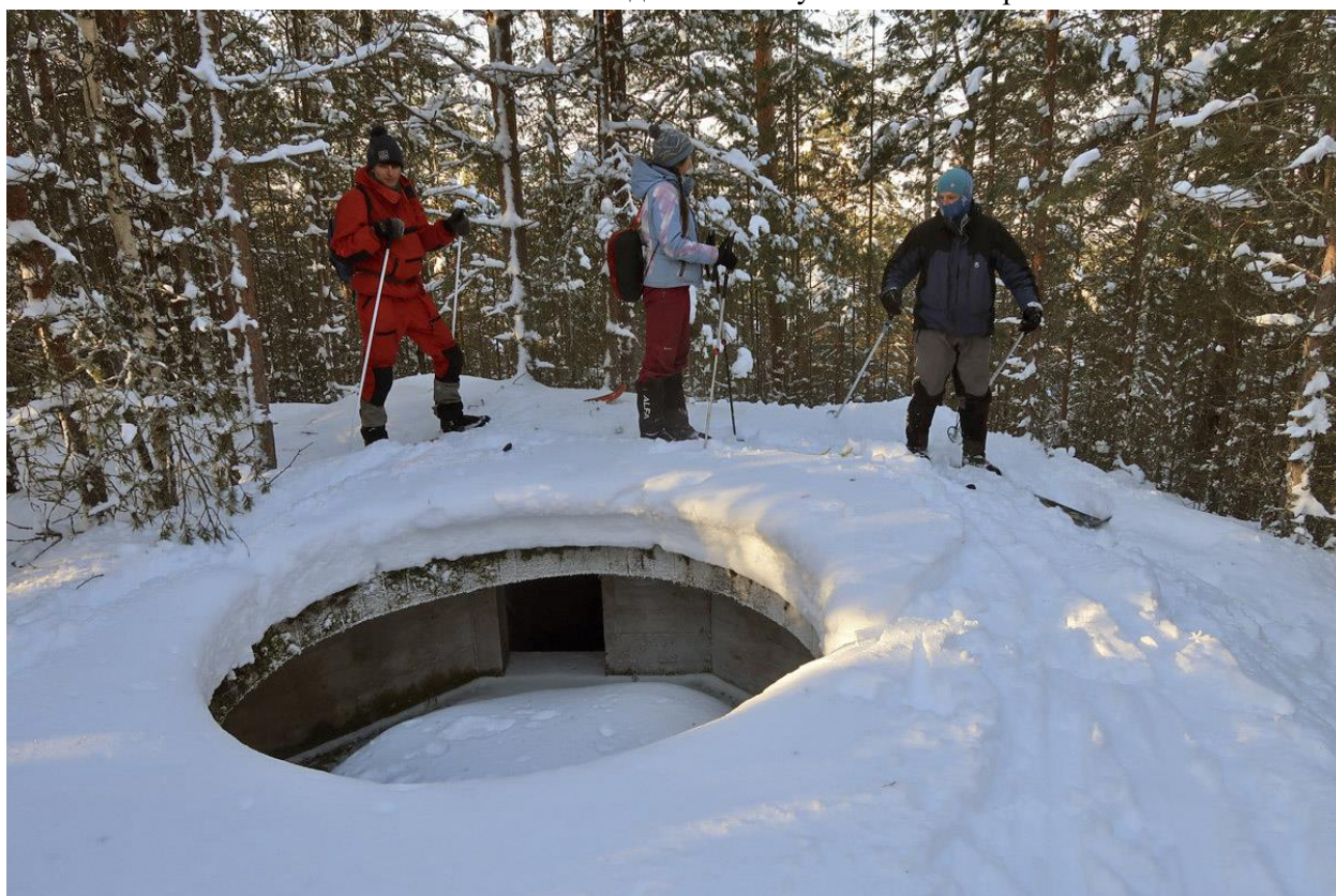
Фото 25. Финский наблюдательный пункт на Мегострове
