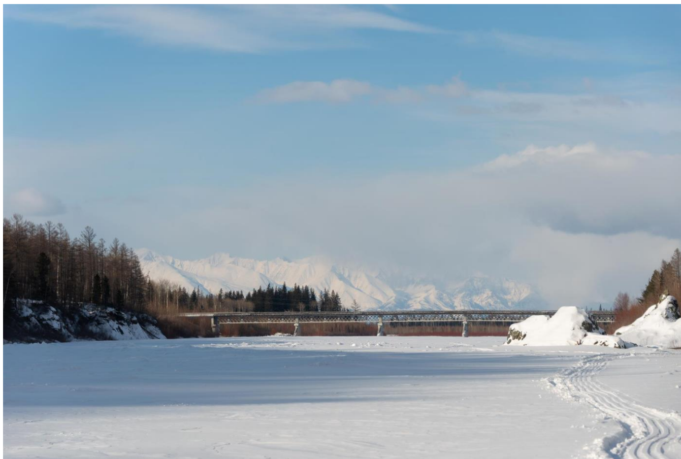
Фото 64. Автомобильный мост через реку Котера. Конец маршрута.
