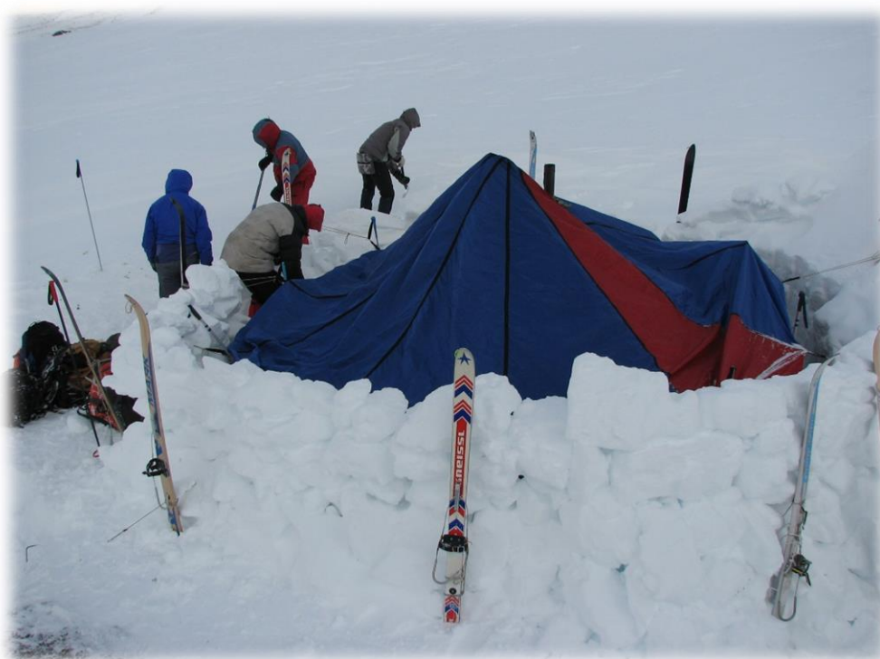
Фото 10. Укрепление ветрозащитных стен
