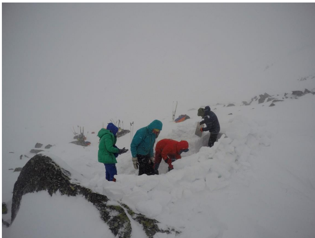
Фото 12/5. Строительство стенки под шатёр в непогоду
