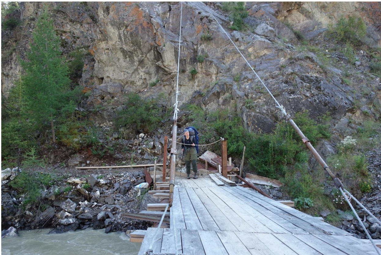
Фото. 116. Идем по мосту через р. Чую
