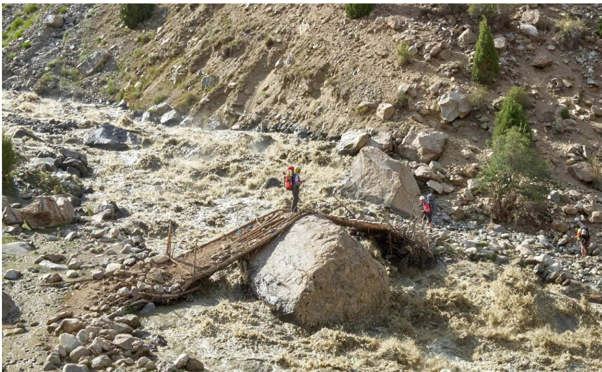
Фото №3. Мост через речку Герез-су вблизи лет. Матча.
