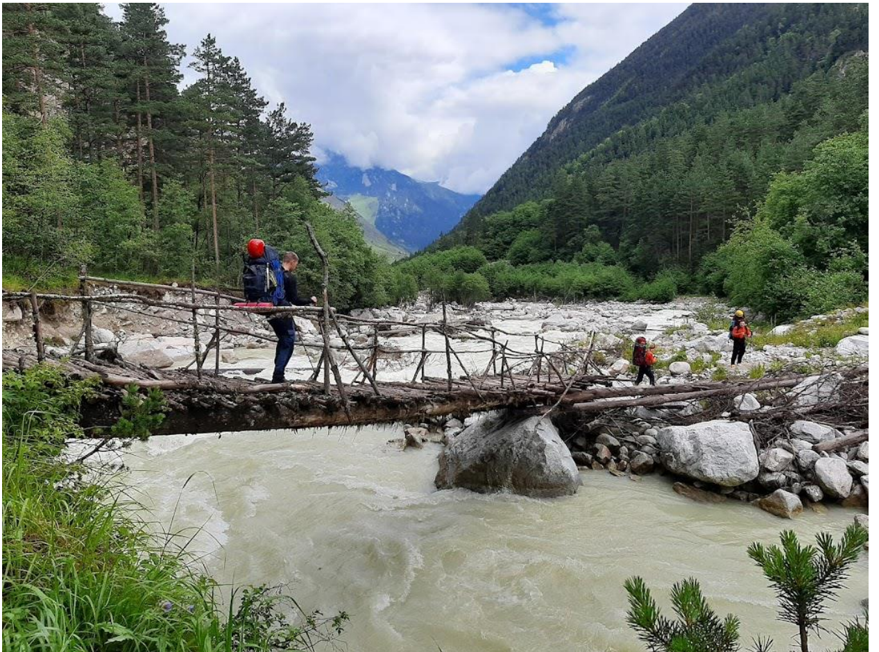
Фото 5.3 Мост через Караугом-дон
