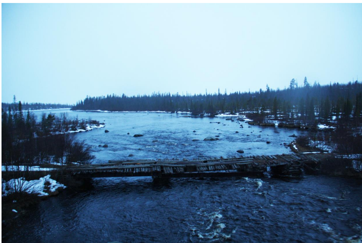
Фото 3. Автомобильный мост через р. Кицу.
