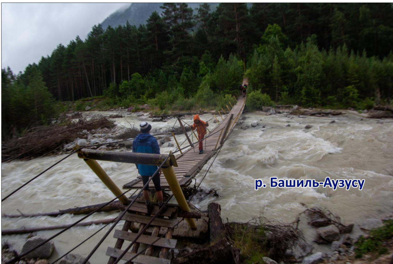
ФОТО 6.9. Мост через реку Башиль-Аузусу.
