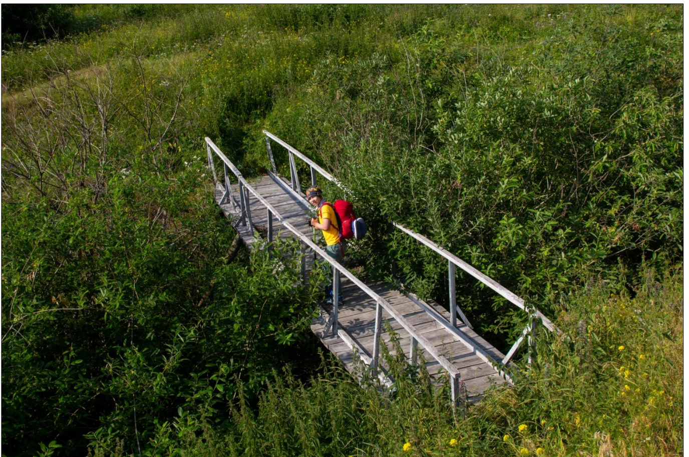
ФОТО 2.6. Деревянный мост через реку Шыкису.
