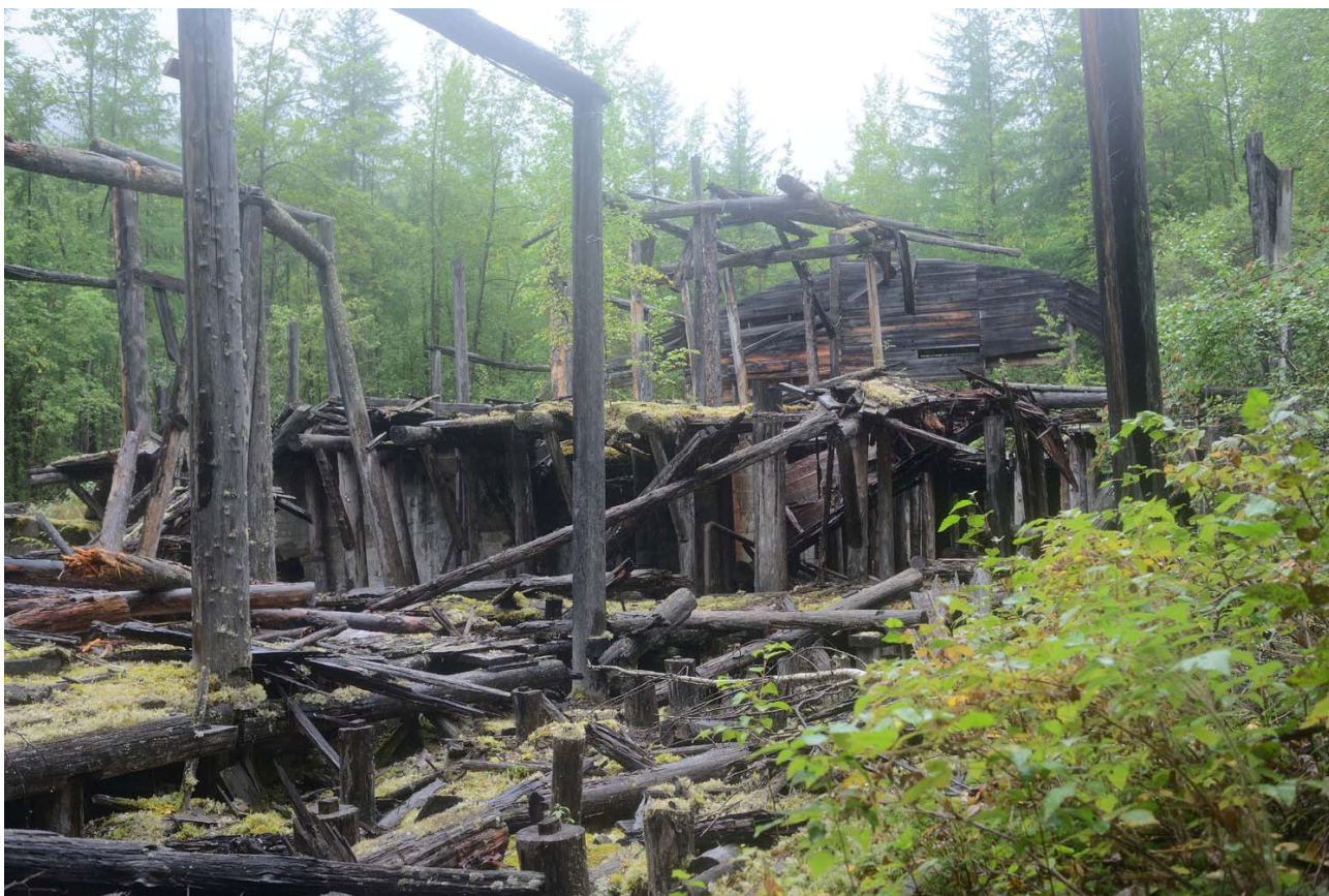
Фото 126. Руины обогатительной фабрики
